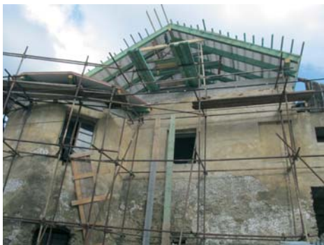
■ Oprava krovu na kaštieli
