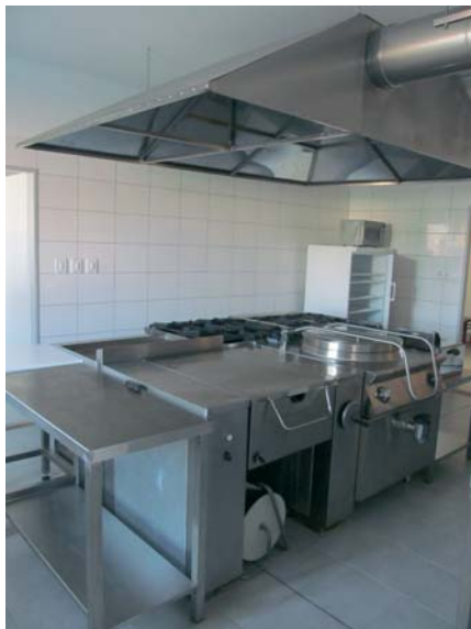
■ Zrekonštruovaná kuchynka v kultúrnom dome
